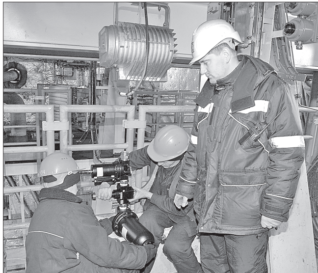
На «Приразломной» полным ходом идут работы
